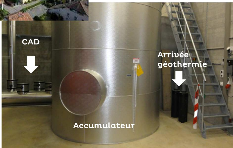
La centrale de chauffage à distance d'Eikenøtt alimentée actuellement au bois et au gaz, prévoyait déjà l'arrivée de la géothermie.
