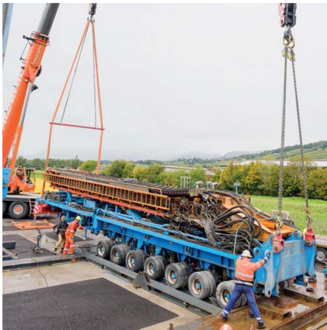
A peine arrivé à Vinzel, vendredi matin vers 9h00, le convoi exceptionnel est déchargé. Ici, deux grues soulèvent la foreuse pour l'installer à son emplacement définitif. CÉDRIC SANDOZ
